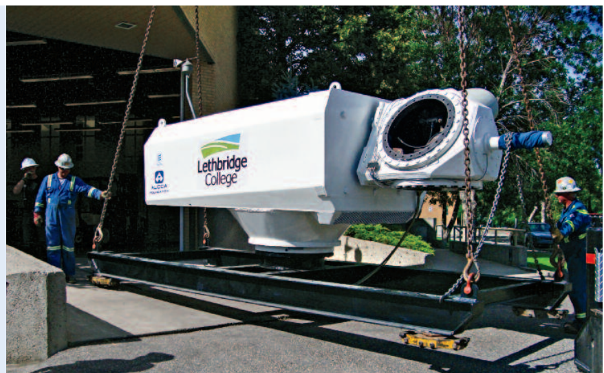
Des ouvriers assemblent l'éolienne au Collège Lethbridge.
